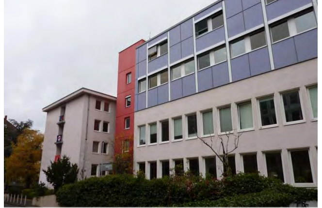
Abb.7: Hinterhaus von Mertonstr.
